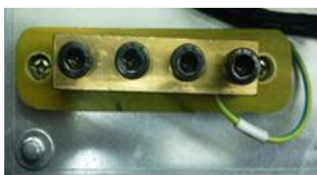
Generator Grounding Bar Lug
